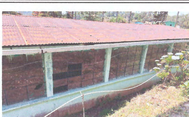
Foto 2: ÁREA DE LA PARTE DE ATRÁS DONDE SE CONTEMPLA REALIZAR EL MEJORAMIENTO DE TECHO, MANTENIMIENTO DE COSTANERAS Y MEJORAMIENTO DE CANALETAS CON SU RESPECTIVA CAIDA DE AGUA.
