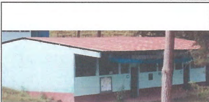
Foto 1: ÁREA FRONTAL DONDE SE CONTEMPLA REALIZAR EL MEJORAMIENTO DE TECHO, MANTENIMIENTO DE COSTANERAS Y MEJORAMIENTO DE CANALETAS CON SU RESPECTIVA CAIDA DE AGUA.
